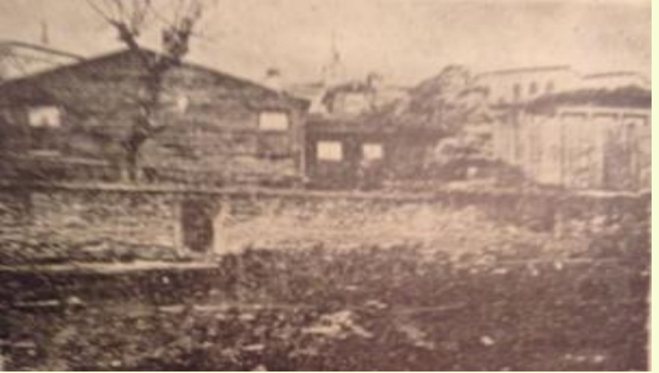
Çatladıkapı'daki Fener Kulesi'ne Uzanan Duvarın Kalıntısı
