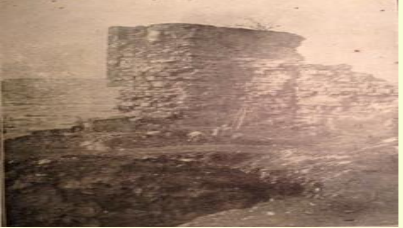
Çatladıkapı'da Odun İskelesi'nde Altmış Metre Açısı Dahilindeki Burcun Şimdiki Hâli
