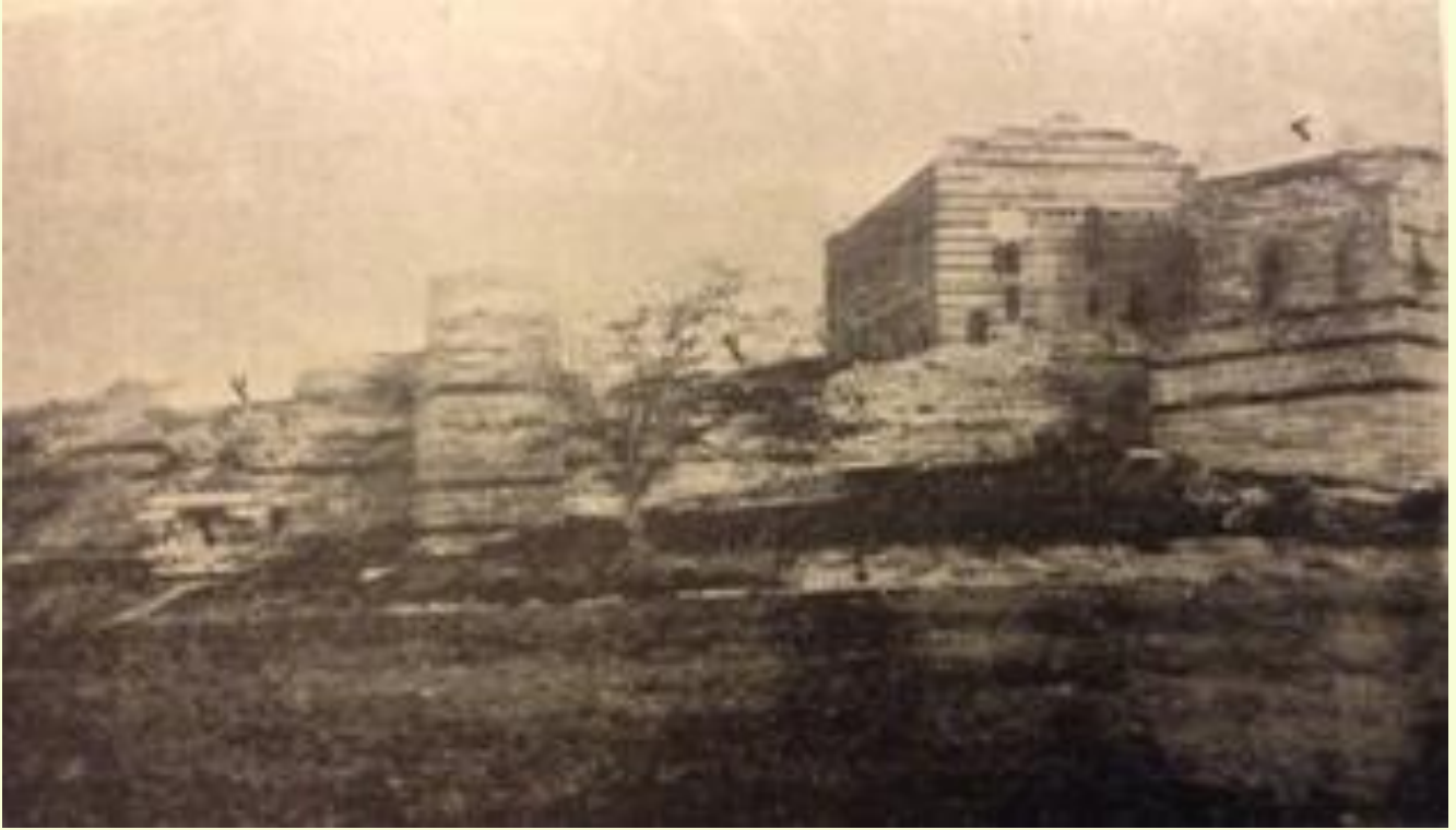
Tekfur Sarayı (1. numara ile gösterilenkapı Porfirianutus yahut Asumatun Kapısı'dır. 2. Mahkeme Kulesi, 3. Teodüsyus Suru,4. Hendeğin iç duvarıdır.)
